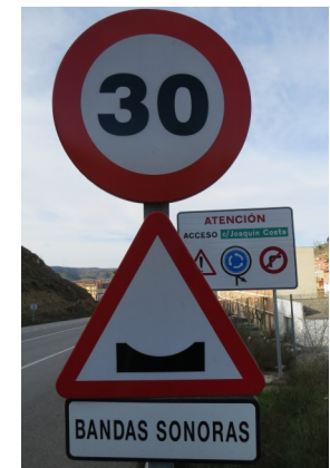
Señal de peligro adaptada a la BTA fresada.
