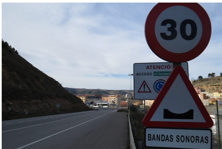
Señalización de BTAs incorrecta por proximidad.
